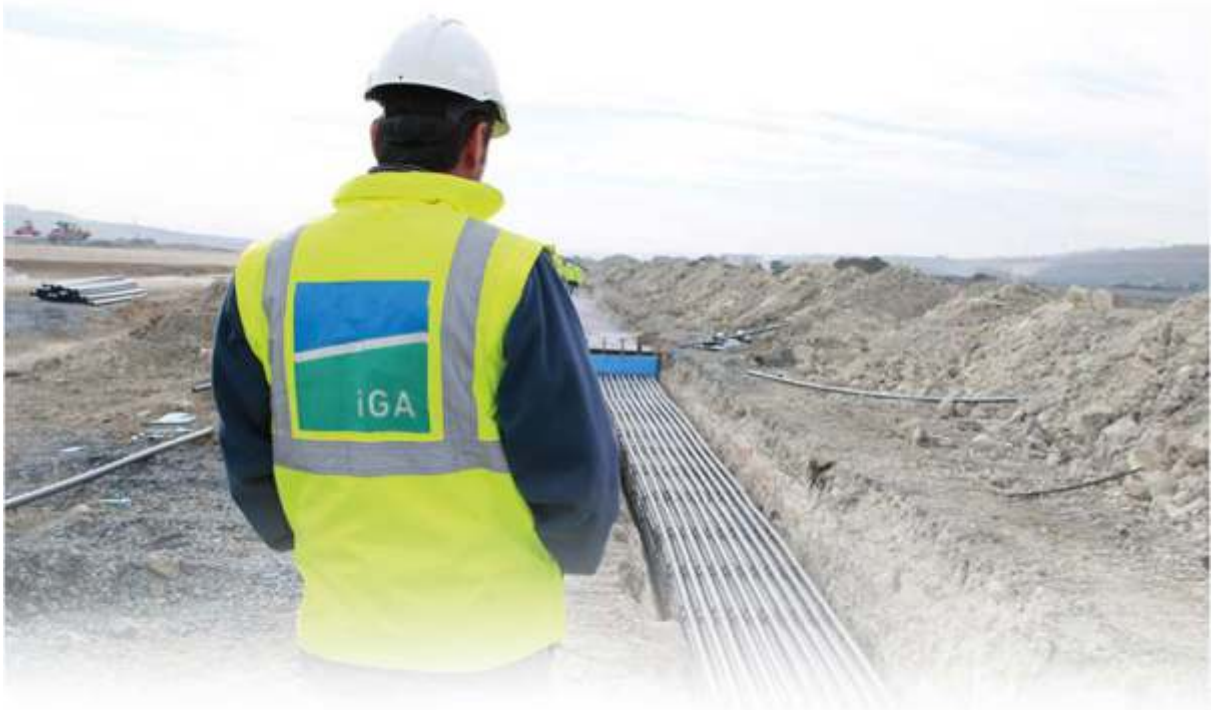
Kablo Geçiş Boru Uygulaması (Istanbul Grand Airport 2017)
